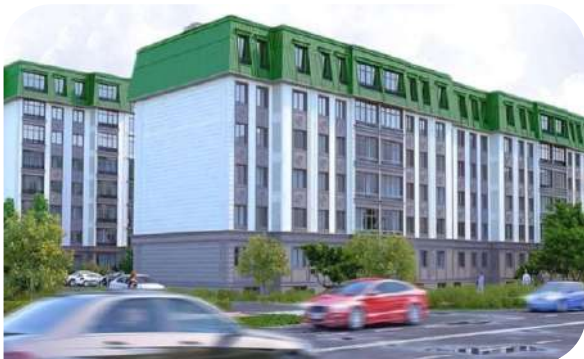
ЖК «Фасыр» г.Актау
